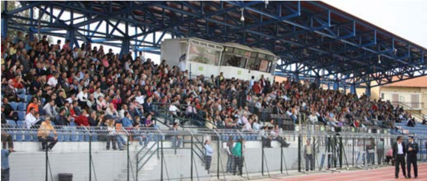
Προτιμότερο να κατεδαφιστούν και να φτιαχτούν καινούριες κερκίδες έκριναν οι Τεχνικές Υπηρεσίες της ΓΓΑ. Η κατεδάφιση ξεκινάει, η μελέτη για την ανέγερση νέων λείπει.
