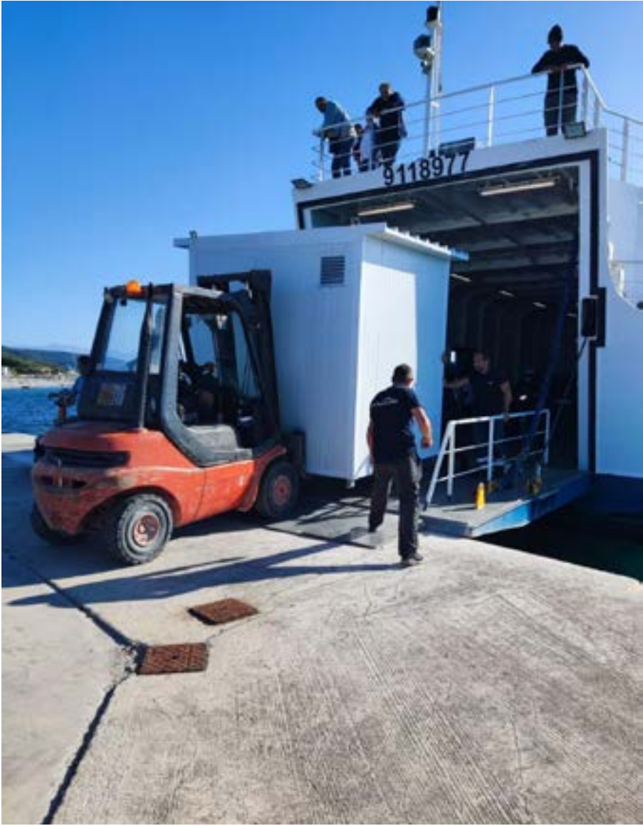
Εγκαταστάθηκε το water kiosk στο Λιμάνι των Οθωνών.
