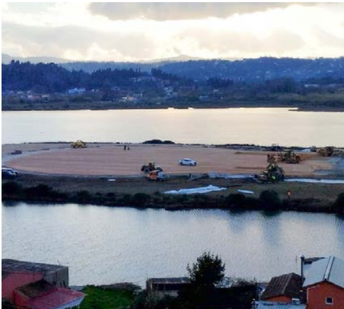
Από τις προηγούμενες φάσεις των έργων στο αεροδρόμιο Κερκύρας, «Ι. Καποδίστριας».
