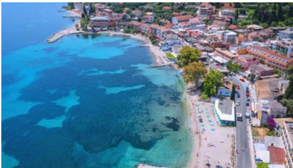
Το έργο αφορά στην κατασκευή υποβρύχιου αγωγού για τη διάθεση των επεξεργασμένων λυμάτων της Ε.Ε.Λ. Μπενιτσών σε απόσταση 400 μέτρων από την ακτή
