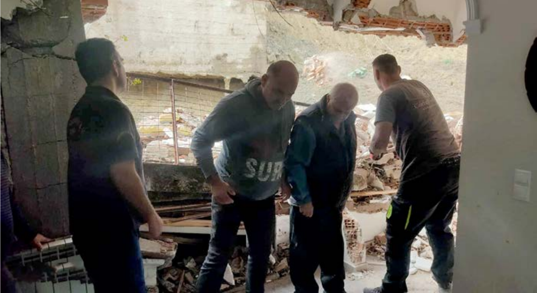
Στον Αφιώνα υποχώρησε το τοίχιο και τα χώματα έπεσαν πάνω στο σπίτι.
