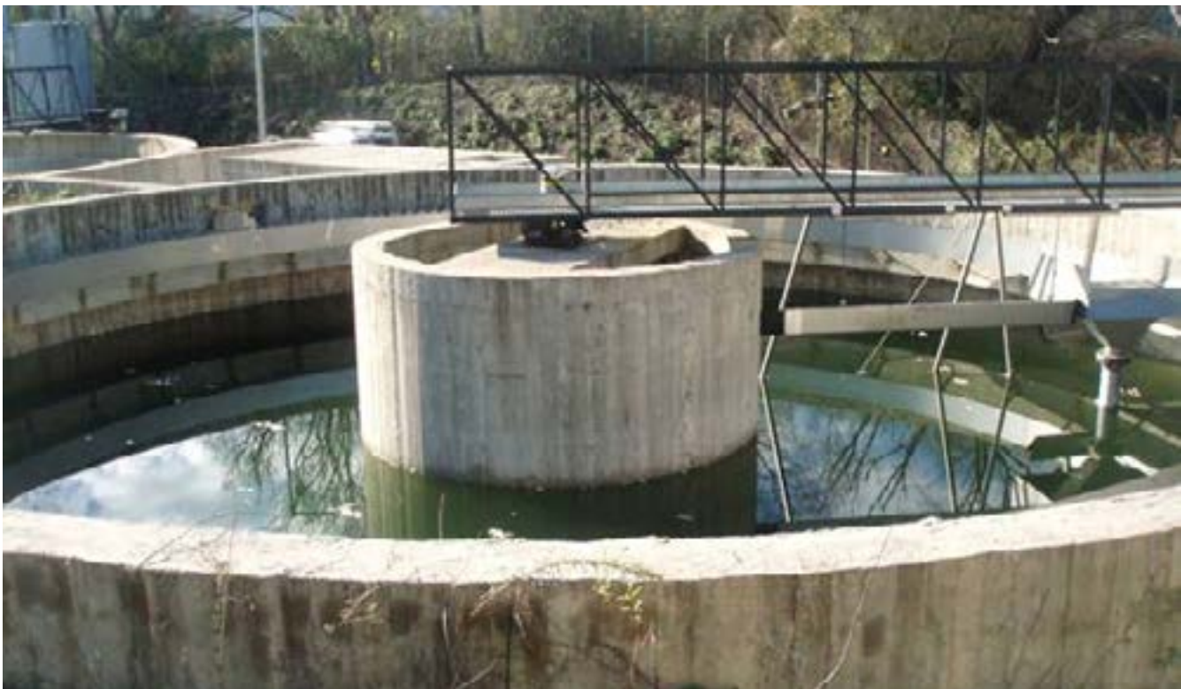
Η Μονάδα βιολογικού καθαρισμού των λυμάτων στο Σιδάρι μαζί με εκείνα της αποχέτευσης στην Κασσιώπη είναι δυο έργα που διχάζουν τις ΔΕΥΑ Κέντρου και Βορρά για το ποιος υποχρεούται να πληρώσει το μάρμαρο.
