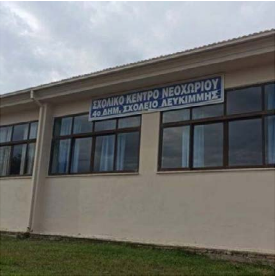
Το Δημοτικό σχολείο στο Νεοχώρι Λευκίμμης
