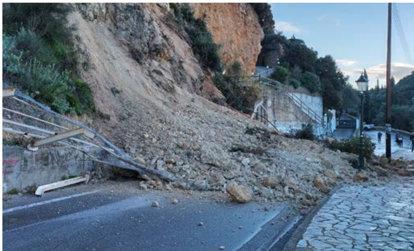
Την εκπόνηση ολοκληρωμένης μελέτης και αναπτυξιακή αναβάθμιση του κυκλοφοριακού της Παλαιοκαστρίτσας, ζητά η ένωση επαγγελματιών της περιοχής με αφορμή την κατολίσθηση.
