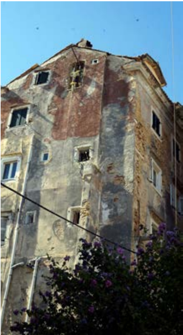
Τα περιστατικά πτώσης σοβάδων δεν είναι μεμονωμένα. Είναι η ορατή πλευρά ενός χρόνιου προβλήματος συντήρησης.
