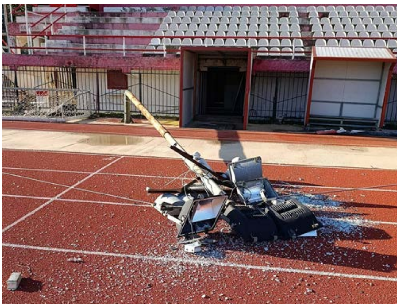
Η σπασμένη κολώνα φωτισμού
