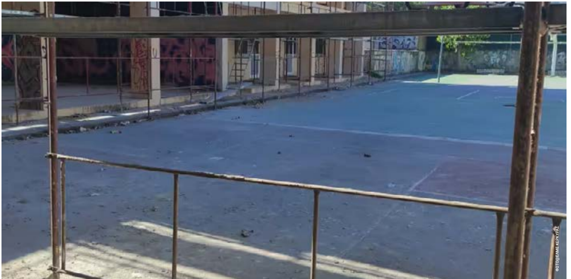
Τα σωματεία των εκπαιδευτικών αναδεικνύουν τη χρόνια κακή κατάσταση των σχολικών κτιρίων και κάνουν λόγο για επικίνδυνη μετακύλιση ευθυνών.
