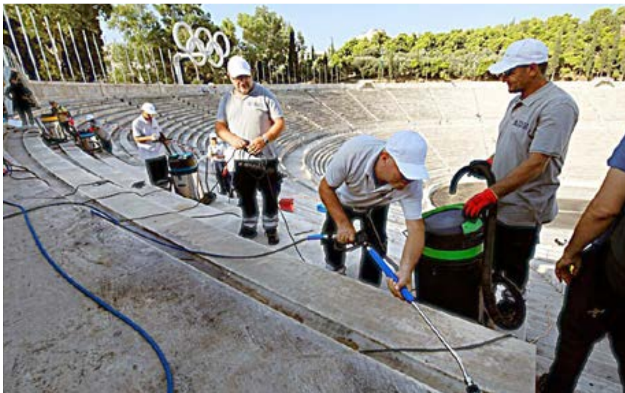
Καλλιμάρμαρο: Ο καθαρισμός των πεντελικών μαρμάρων γίνεται με καθαρό νερό, χαμηλή και ελεγχόμενη πίεση και ειδικό εξοπλισμό, υπό επιστημονική εποπτεία και με βασική προϋπόθεση τη διατήρηση της πατίνας του χρόνου.
