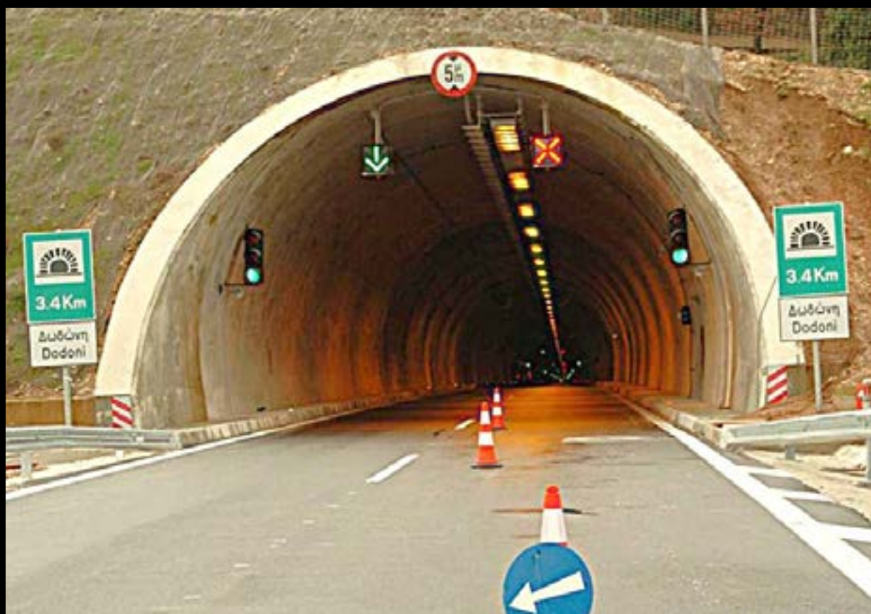
Σε δρόμο μίας λωρίδας έχει μετατραπεί σε μεγάλα τμήματά της η Εγνατία Οδός μετά την παραχώρησή της, με χαρακτηριστικότερο ένα συνεχόμενο τμήμα περίπου 29 χιλιομέτρων στην Πίνδο.
