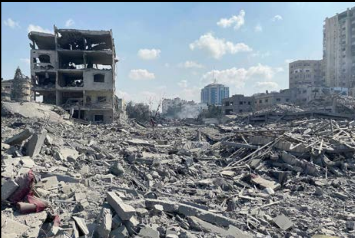
Εκτεταμένες καταστροφές σε κτίρια κατοικιών στη συνοικία Ριμάλ της πόλης της Γάζας.
