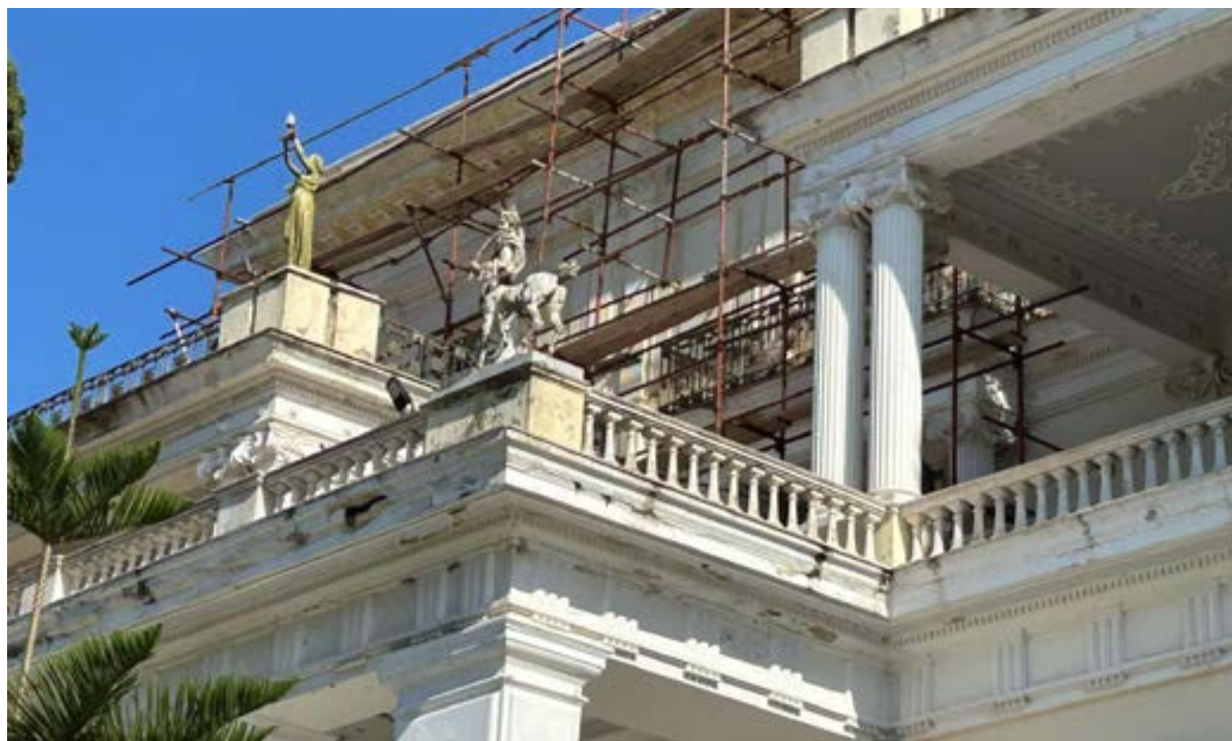
Το Αχίλλειο πίσω από τις σκαλωσιές. Η αποκατάσταση του εμβληματικού μνημείου παραμένει σε εκκρεμότητα, με το νέο χρονοδιάγραμμα της ΕΤΑΔ να τοποθετεί την ολοκλήρωση των εργασιών τον Ιούνιο του 2029.
