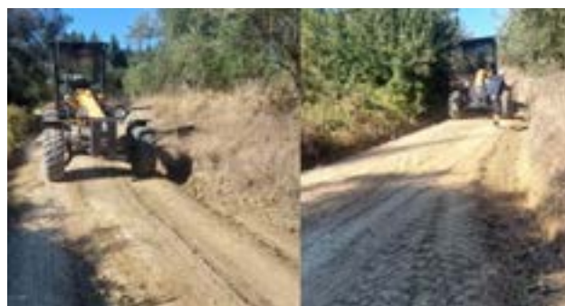
Από τον καθαρισμό των αγροτικών δρόμων
