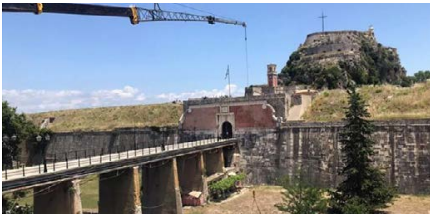
Η ιστορική γέφυρα του Παλαιού Φρουρίου, πάνω από την Κόντρα Φόσσα. Η αποκατάστασή της, μαζί με τη στερέωση του δυτικού αναλήμματος, δημοπρατείται με προϋπολογισμό 3,1 εκατ. ευρώ.
