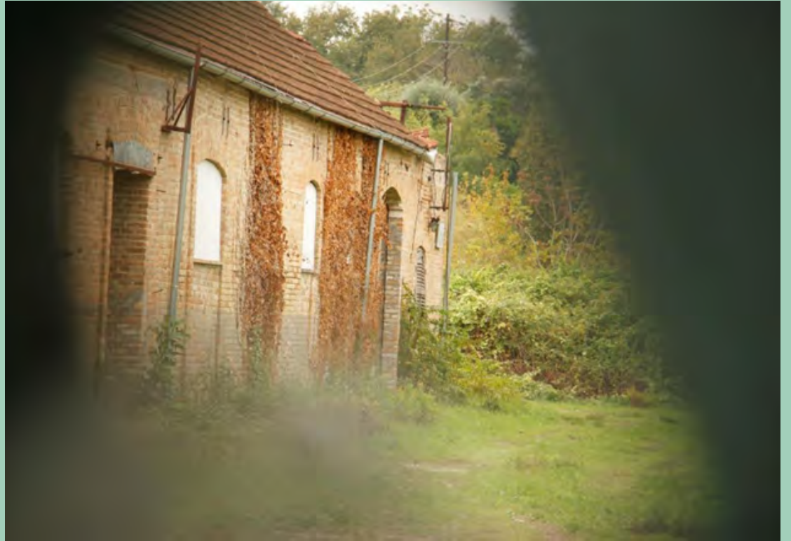
Σημερινή άποψη του εργοστασίου Δεσύλλα
